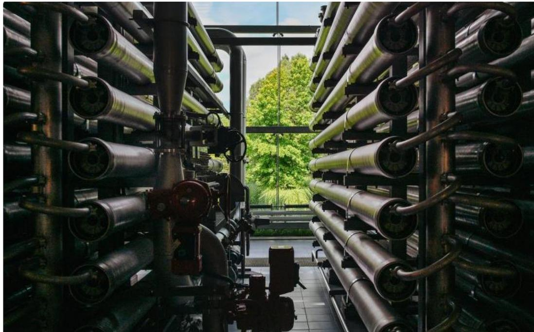
*MEMBRANES DE NANOFILTRATION À L'USINE DE MÉRY-SUR-OISE INSTALLÉE DEPUIS 1999*
